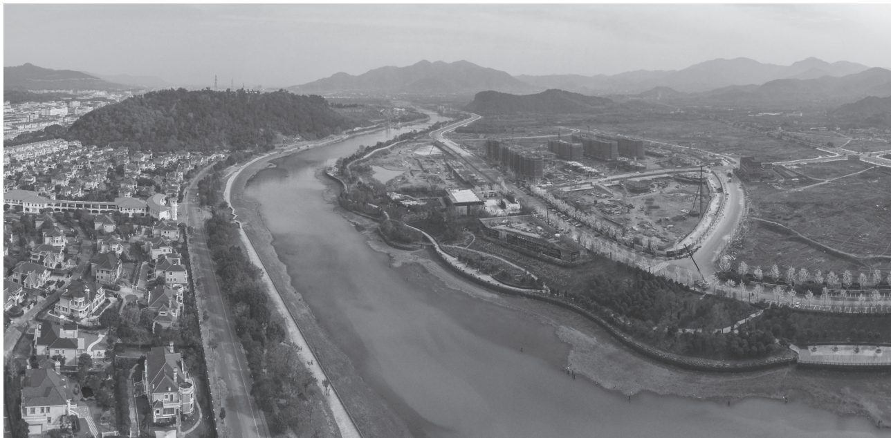
湖山新城建设工地
