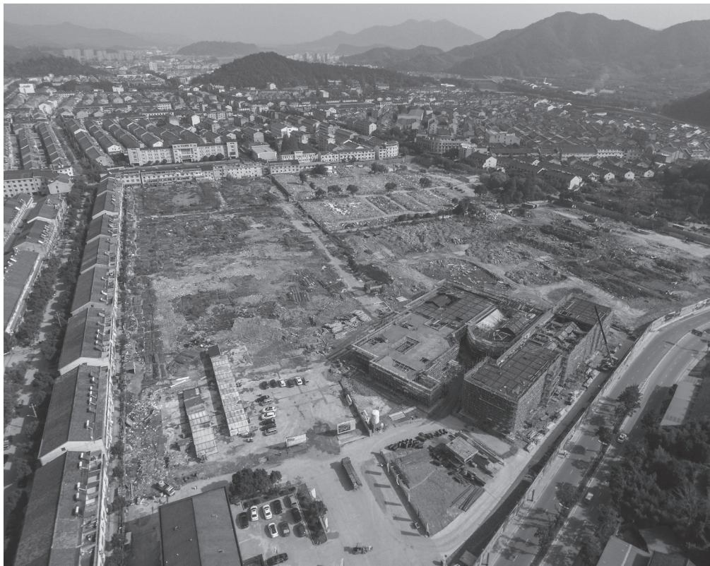
民国风情街建设工地鸟瞰图
