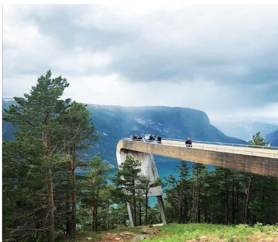
为了使观景能更具戏剧性，设计团队认为营造一种离开山体的体验非常重要，希望观景台以宽阔、开敞的峡湾中的一座桥的形象出现，创造独特的观景视角。让游客产生走出山景、来到新的视点的感受。保护这一区域原有的景观和植被不被破坏也至关重要。因此，观景台本身最终的形式是一座悬挑在空中、可以让游客走上前的桥。桥宽4米，长30米，尽头处高9米。
