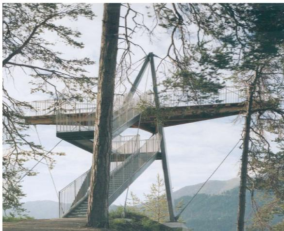
1.3 万年前，上一个冰河时代的结束造成了弗利姆斯山的大崩塌。莱茵河开始侵蚀其岩体，形成了莱茵河谷的天然奇观。这座峡谷是一处国家自然保护区，游客站在观景台上即可以领略其风光，无需走下山。在森林的外缘，这座观景台屹立于群松之间，并伸入山谷之中，且不破坏数千年演化而成的石灰岩构造。从步道上，深色的钢结构在挺拔的树干之间仿佛与森林浑然一体。游客登上螺旋楼梯，就能走上展开的扇形木平台。从远处看，浅色的落叶松木梁、展开的双层椽和锥形的楼板段面犹如一艘启航的帆船。这座与主梁分离的平台由钢索从端部悬挂起来。这些基本要素及其线性的连接形成了一种圆形的内在空间造型。除必要的静力学和构造要求外，其结构
