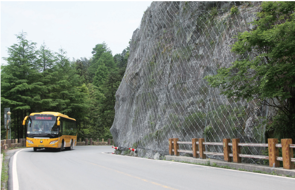
“铜墙铁壁”安全行车
