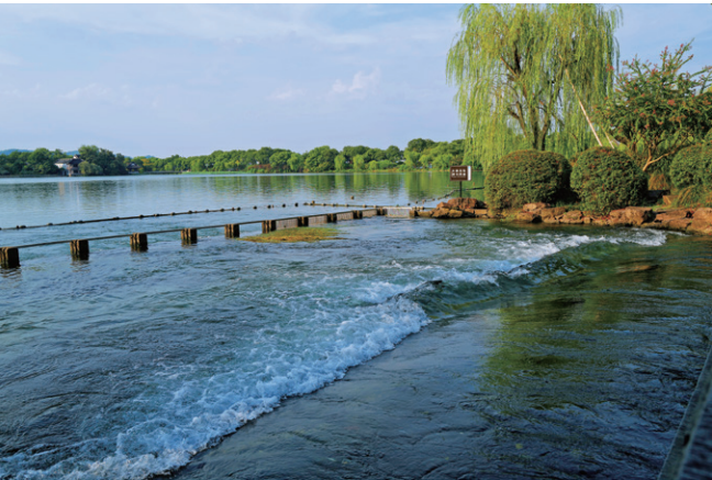
▲小南湖处的西湖入水口，钱塘江江水沿着九曜山输水隧洞，流经太子湾明渠，穿过南山路，注入小南湖。（停香 摄）
